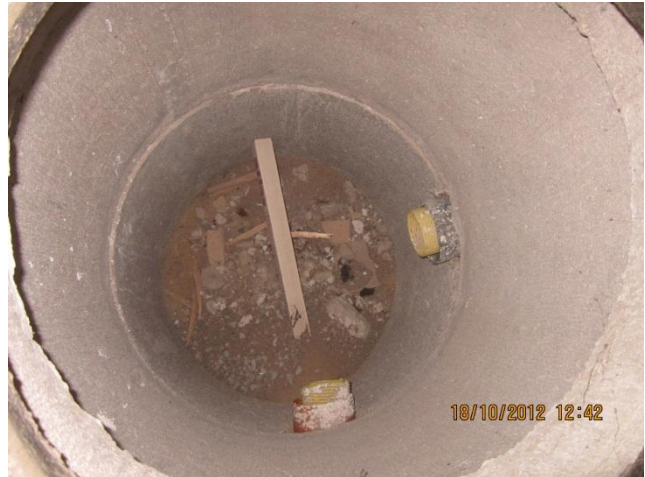
kuva 6 Alustatilan salaojakaivo oli tarkastushetkellä kuiva.
