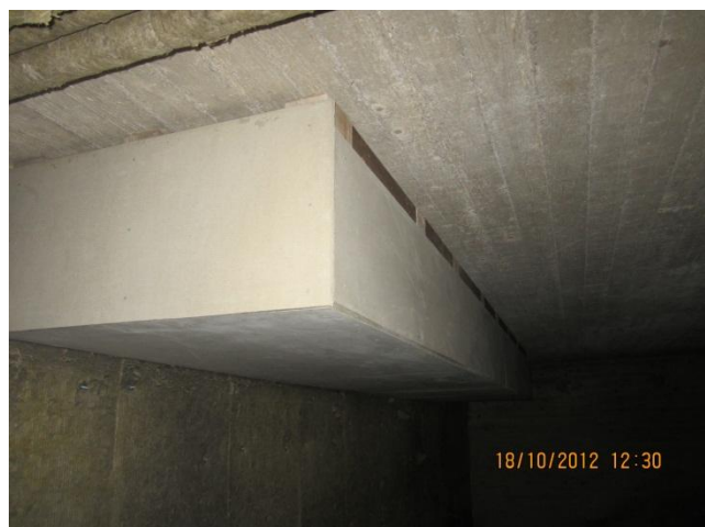
kuva 14 Alustatilan katossa on lujalevykotelo.
