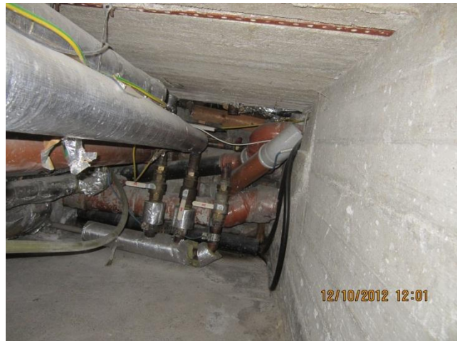
kuva 2 Lämmönjakohuoneen kohdalla kulkeva putki- kanaali.
