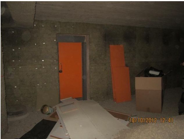
kuva 7 Alustatilan lämpimiä tiloja vasten olevissa seinissä on villaeristys. Tilassa on jonkin verran ylimääräistä tavaraa.
