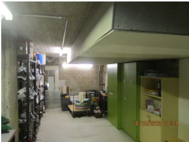
kuva 11 Varastotilan katto ja seinät ovat betonia. Alapohjan betonipinta on maalattu. Katon kotelo on tehty lujalevystä.
