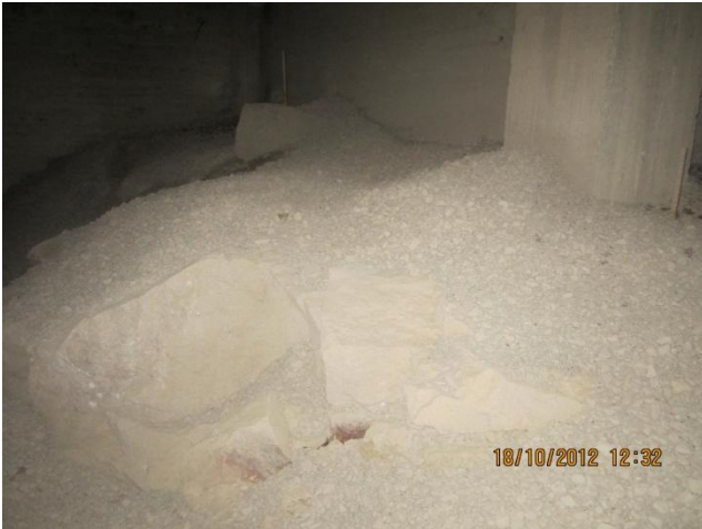
kuva 5 Alustatilassa on peruskalliota näkyvissä.
