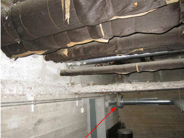
kuva 5 Alustatily 4 tuuletuksesta vastaava kanavapuhallin.
