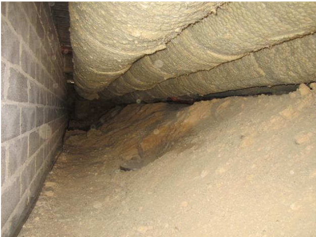
kuva 30 Alustatilassa on mm. ilmanvaihtokanavia.
