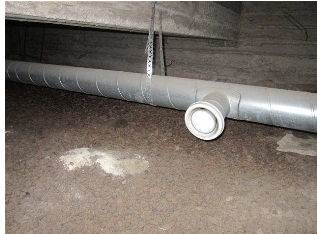
kuva 14 Sepelin pinnalla on mikrobi- ja sienikasvustoa.
