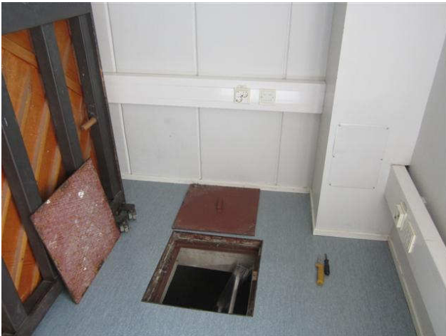
kuva 23 Kulkuluukku alustatilaan on tyypillinen 2-osainen luukku.
