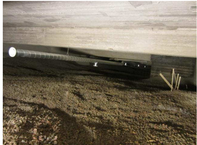
kuva 24 Pintamaana on käytetty pesemätöntä sepeliä.
