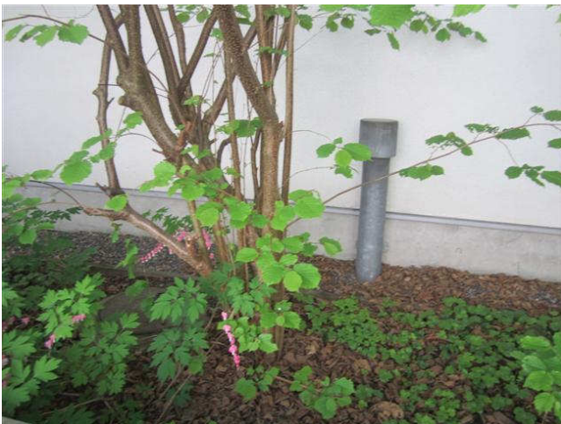
kuva 7 Sisäpihalla oleva alustatily tuuletusputki
