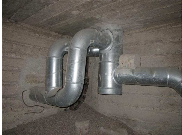
kuva 6 Alustatilyiden 1, 2 ja 3 poistokanavat yhdistyvät yhteiseen pystykanavaan.
