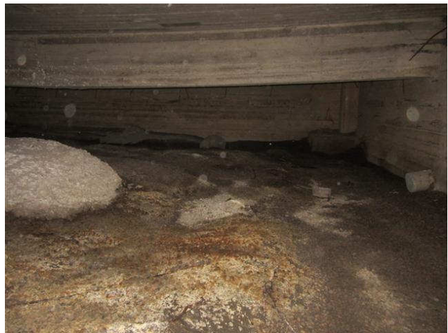
kuva 18 Sepelin pinnassa on vaaleaa mikrobi-kasvustoa.
