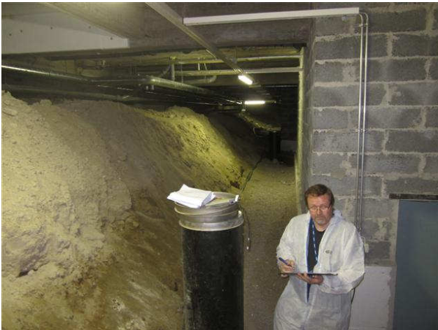
kuva 28 Hiekkaa on kerääntynyt suuriksi kasoiksi, joiden alla on savipenger.
