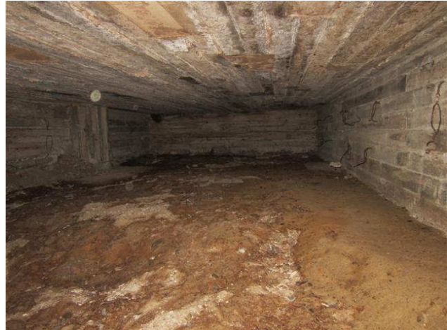
kuva 12 Pintamaana on vain hienojakoista hiekkaa / sientä, jossa on mikrobikasvustoa.
