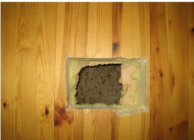
Betoni märkää, irtovettä ei näkynyt välitilassa.
