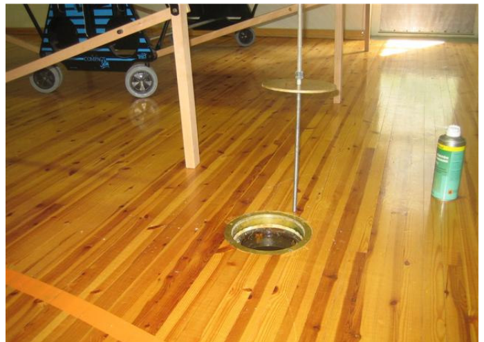
Rekkitangon telineen reiät täynnä vettä ja vesi valunut myös tätä kautta välitilaan.
