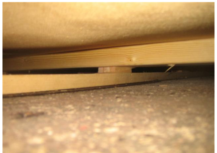
Kuva välitilasta. Lattiarakenne: Parketti, 5cm villa, pahvilevy, välitila, betoni.
