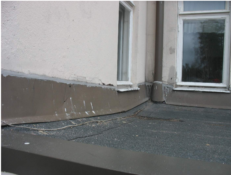
Kuva 7. Katoksen liittyminen seinään. Katoksen juuripellit ovat rappauspinnassa elastisella saumamassalla kiinni. Tämä liitos on korjattava rappauksenosalta liitospellillä joka rapataan osaksi seinäpintaa.
