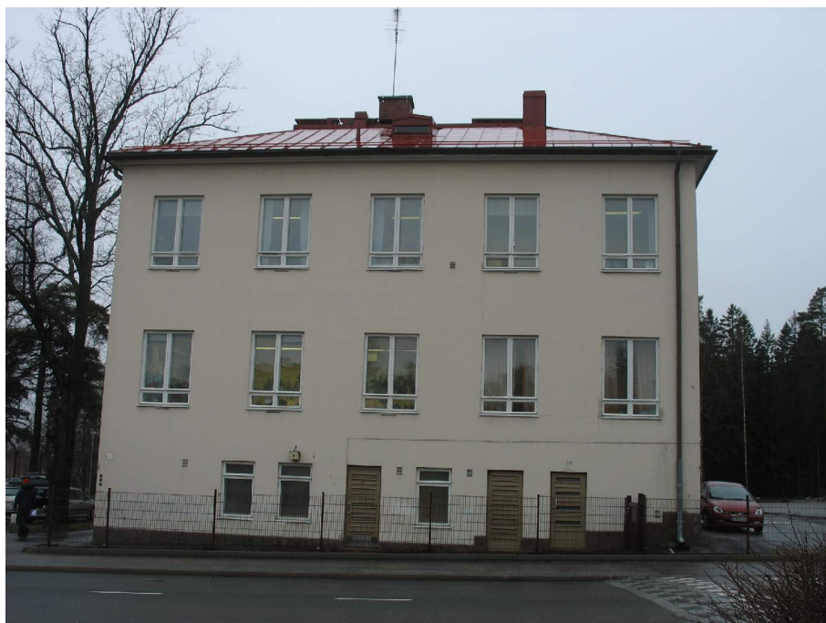
Kuva 2. Yleiskuva julkisivusta itään, rakennuksen vanhasta osasta.
