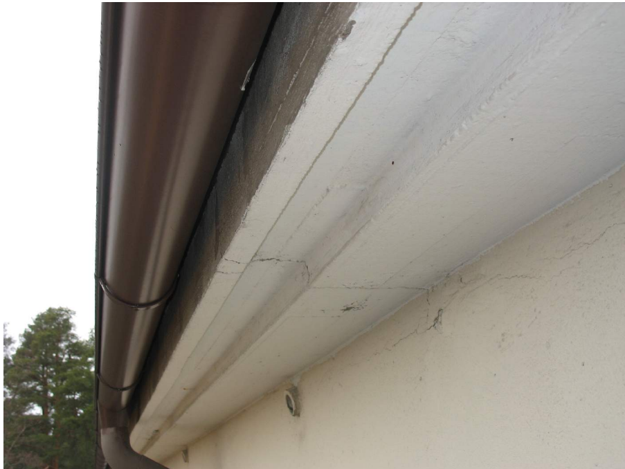
Kuva 7. Katoksen liittyminen seinään. Katoksen juuripellit ovat rappauspinnassa elastisella saumamassalla kiinni. Tämä liitos on korjattava rappauksenosalta liitospellillä joka rapataan osaksi seinäpintaa.
