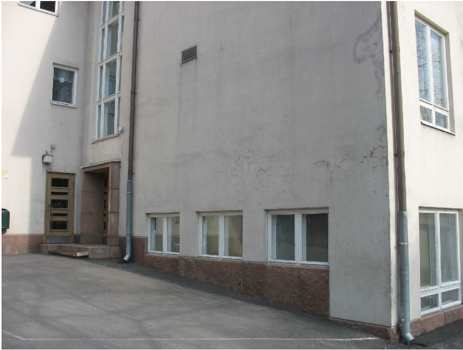
Kuva 3. Länsipääty, päätyseinän takana on keittiötilat, jonka poikkeuksellinen kosteus saattaa aiheuttaa seinässä rappauksessa maalipinnan irtoilemista. Tämantyyppistä halkeilua ja lohkeilua ei esiinny muualla.
