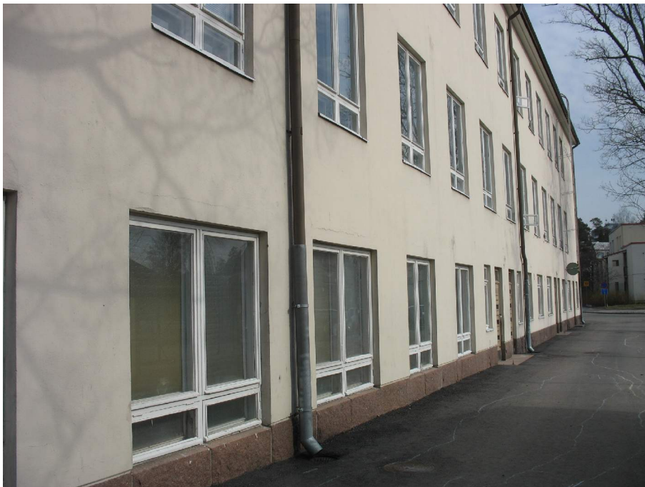
Kuva 3. Länsipääty, päätyseinän takana on keittiötilat, jonka poikkeuksellinen kosteus saattaa aiheuttaa seinässä rappauksessa maalipinnan irtoilemista. Tämantyyppistä halkeilua ja lohkeilua ei esiinny muualla.
