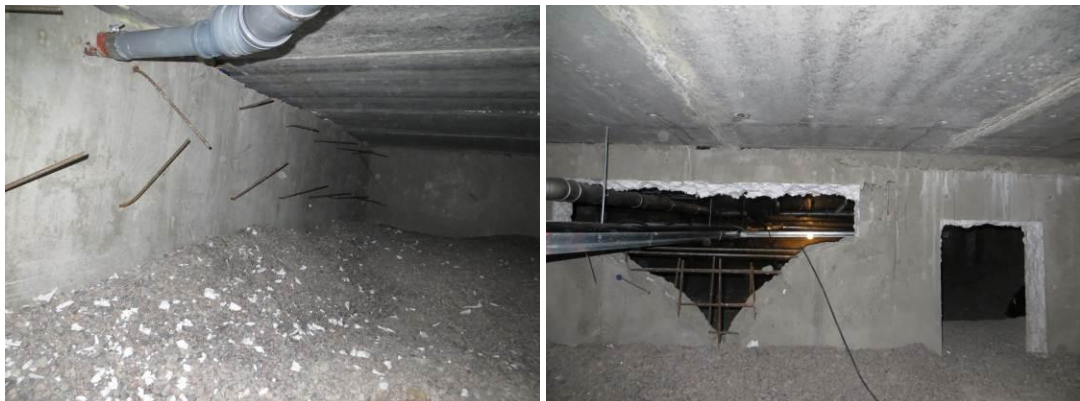
Kuvat 4a ja 4b. Vasemmalla perusmuurin sidosteräksiä kulkuaukon vierellä. Oikean puoleisessa kuvassa on sähkö- ja viemäriveroja varten tehty aukko salin 1004 alla, jossa on jäänyt valuvaiheessa nk. rotankolo.
