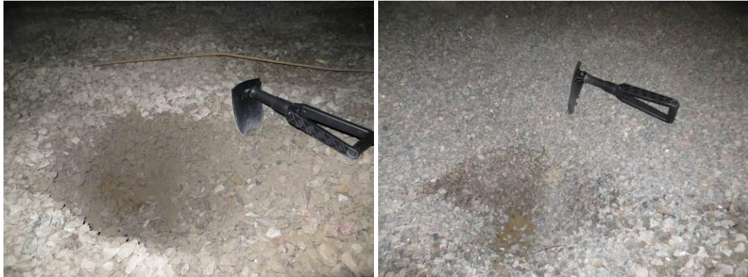
Kuvat 2a ja 2b. Koekuoppa ryhmätila 1075 alla, syvyys n. 370 mm. Kaivukohdalla kosteaa murskettä, lisäksi hienoa hiekkaa, pohjalla on musta suodatinkangas. Oikealla koekuoppa liikuntasali 1004 alla, jossa ensin sepeliä # 6–16 mm ja sitten kosteaa murskettä, jonka alla on hienoa hiekkaa.
