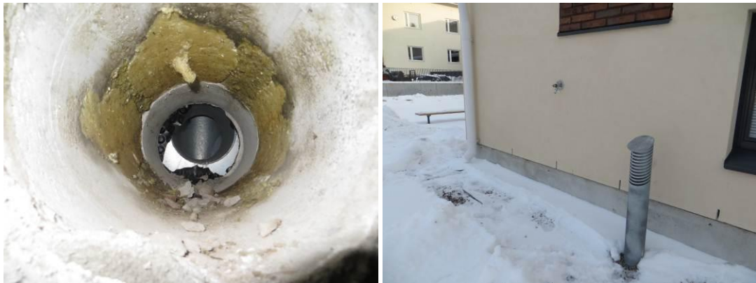
Kuvat 5a ja 5b. Tuuletusputken pää sokkelipalkin läpi ryömintätilaan. Tuuletusputki nousee riittävästi maan pinnan yläpuolelle. Ritilöistä pääsee tuiskulunta.
