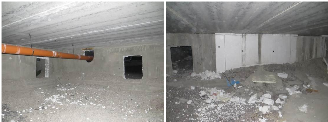
Kuvat 3a ja 3b. Kulkuaukkoja ryömintätilojen välisissä perusmuureissa. Perusmuuria vasten oleva lämmöneristys salin sivulla pukuhuoneen 1017 alla vasten perusmuuria, jonka takana on paikallavalulaatta väestönsuojan kohdalla. Ryömintätilassa on vielä rakennusjätettä.
