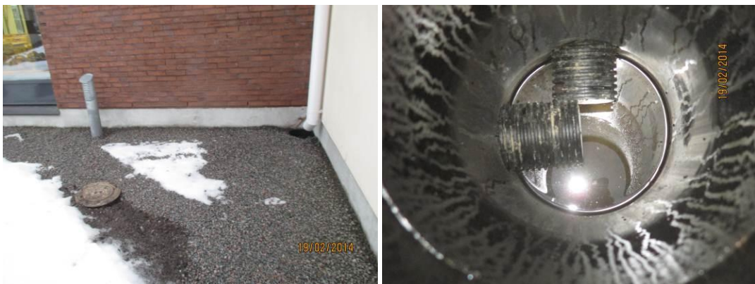
Kuvat 13a ja 13b. Tarkastettu salaojan tarkastuskaivo, joka on etäällä rakennuksesta läh. neuv. 1085.
