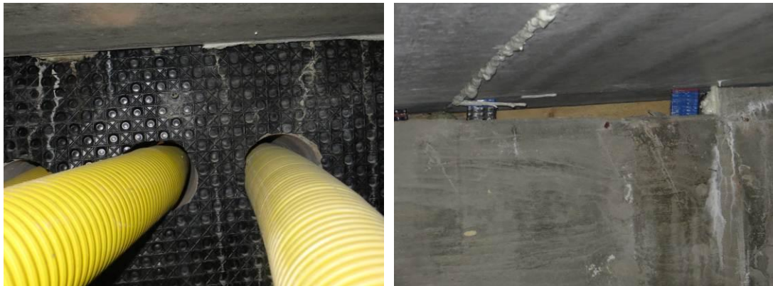
Kuvat 12a ja 12b. Tästä on läpivientireikien kautta ilmayhteys koulun kellarikäytävälle. Koulun päätyseinän alla oleva rako, josta pilkottaa vaneri. Onteloiden alla ei ole saumavalua.
