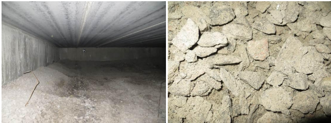
Kuvat 1a ja 1b. Tyypillistä alustatilaa, ryhmähuone 1077 alla, korkeus 1200–1400 mm. Maapohjana on hienoaineksia sisältävää murskettä.
