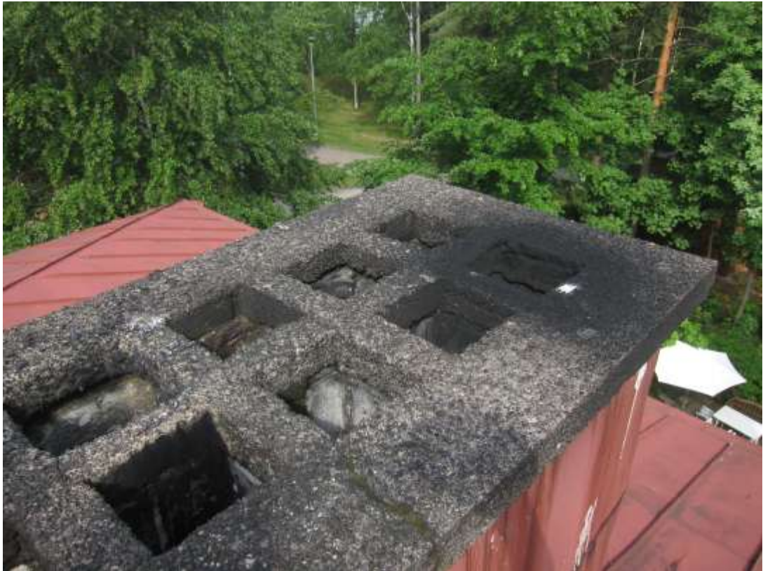
KUVA R23. Piippu. Savuhormin ympäristössä runsaasti nokea.
