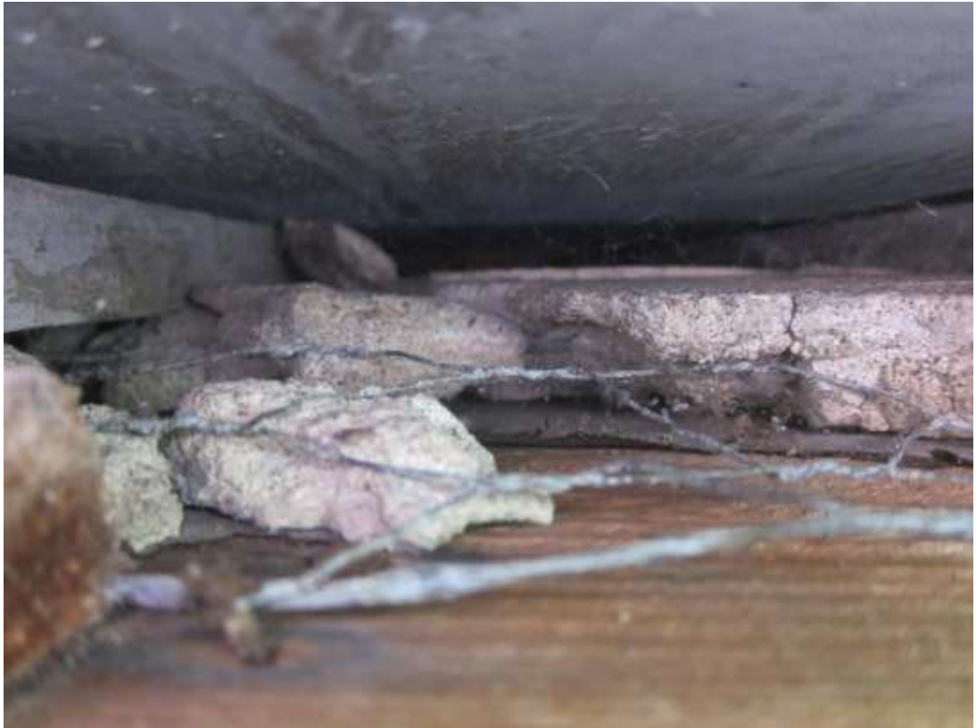
KUVA R9: Rappaus Minerit- verhouksen alla, kuva otettu verhouksen alapäästä ylöspäin.
