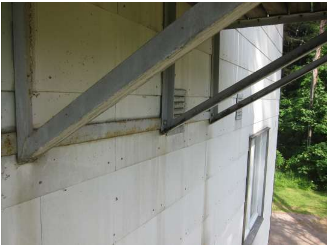
KUVA R14. Parvekkeen ankkurointi seinään täkkipulteilla.
