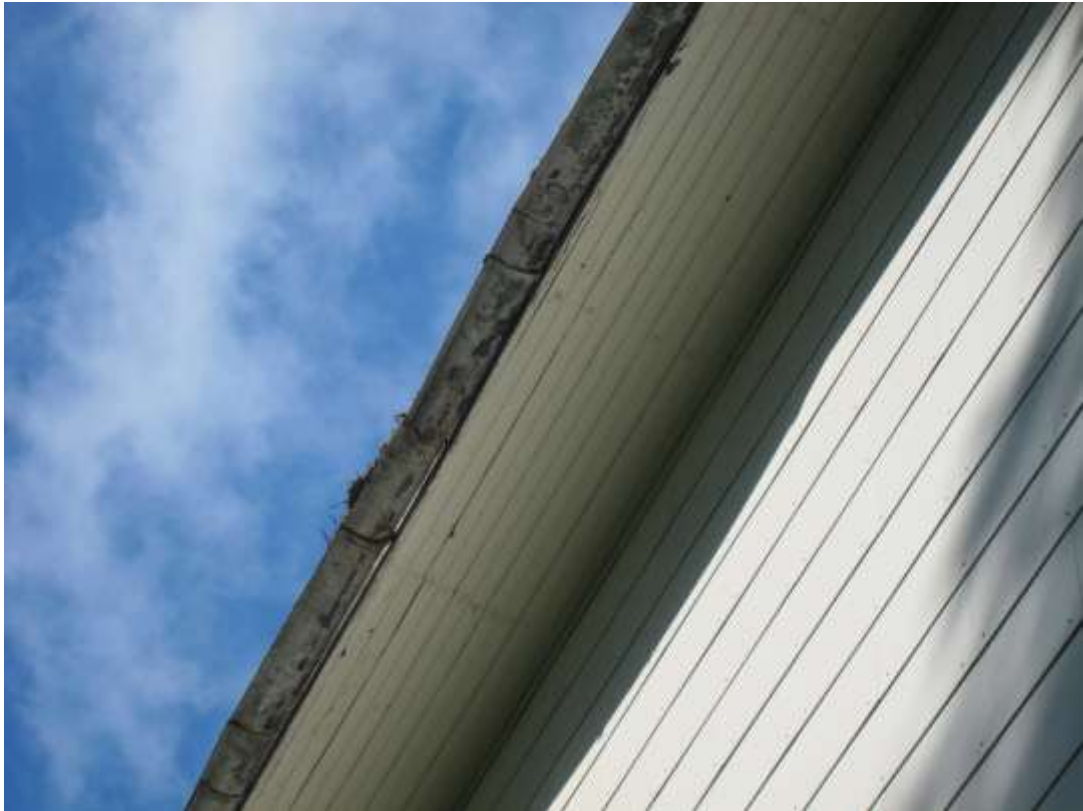
KUVA R17. Kourut ovat vääntyneet, ja niissä on eloperäistä roskaa.
