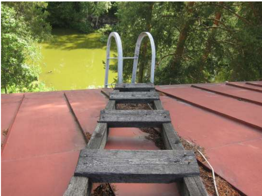
KUVA R22. Haristunut ja jalan alla hieman myötäävä vanha lapetikas.
