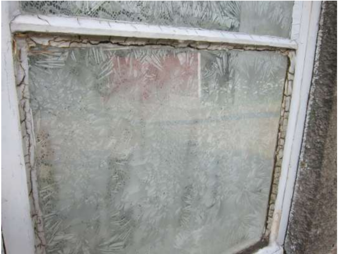
KUVA R11. Puikkunoiden ulkopuitteissa maalipinta ja kittaukset ovat säänmukaisesti vaurioituneet eri puolilla rakennusta.
