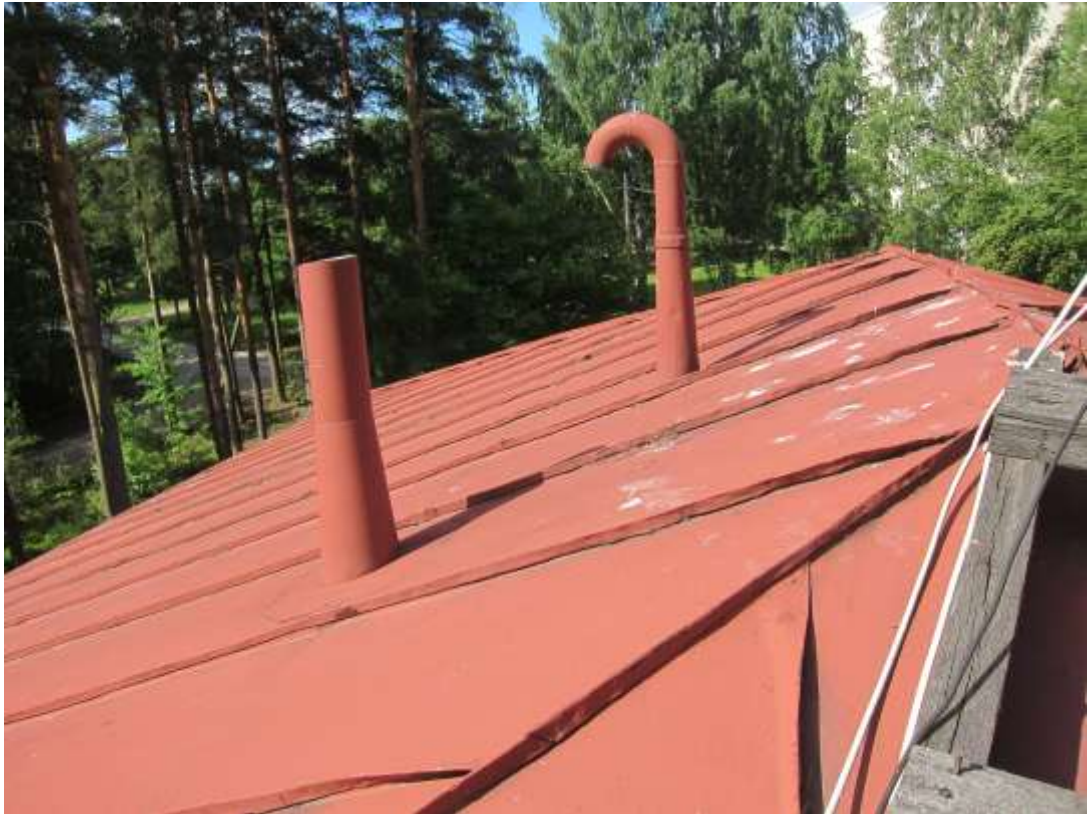
KUVA R21. Yleiskuvaa vesikatteesta.
