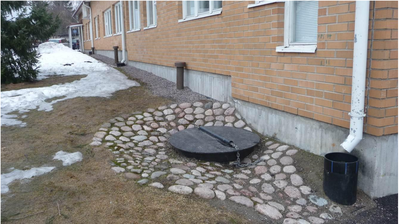
Kuva 5. Päärakennuksen tuuletetun alapohjan osan länsisivu
