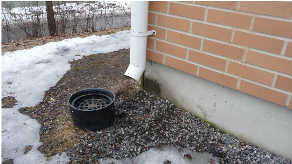
Kuva 3. Osa syöksyputken vedestä menee ohi.
