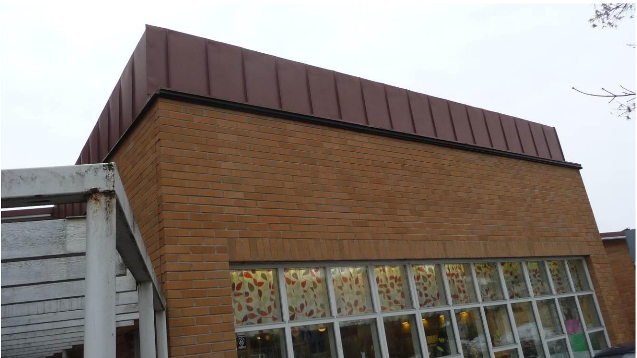
Kuva 8. Koulun ruokalan alue. Ulkoasu siisti. Katos alkavaa ruostumista palkeissa
