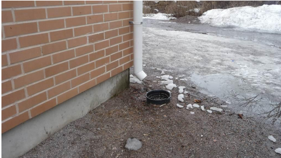
Kuva 3. Osa syöksyputken vedestä menee ohi.
