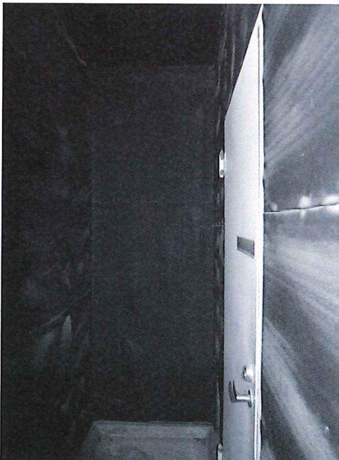
Kuvat 10,11,12. Raitisilmakammion seinämät oli vuorattu solumuovila. Solumuovien väleissä oli rakoja, joista näkyi vanha villa. Tuloilmakoneiden jälkeisten kanavien reikäpeltien takana oli villaa.
